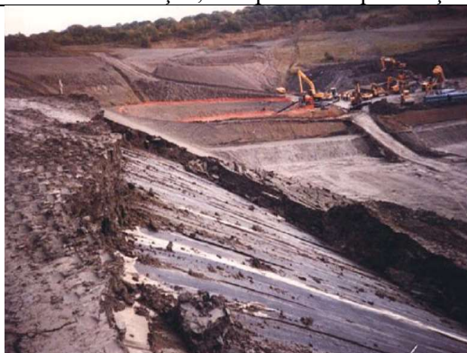
Figura 01. Ruptura de interface em aterro sanitário.
