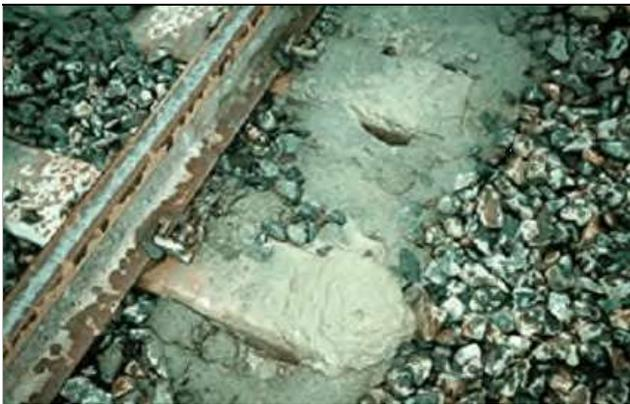
Figura 01. Bombearamento de finos em ferrovia.
